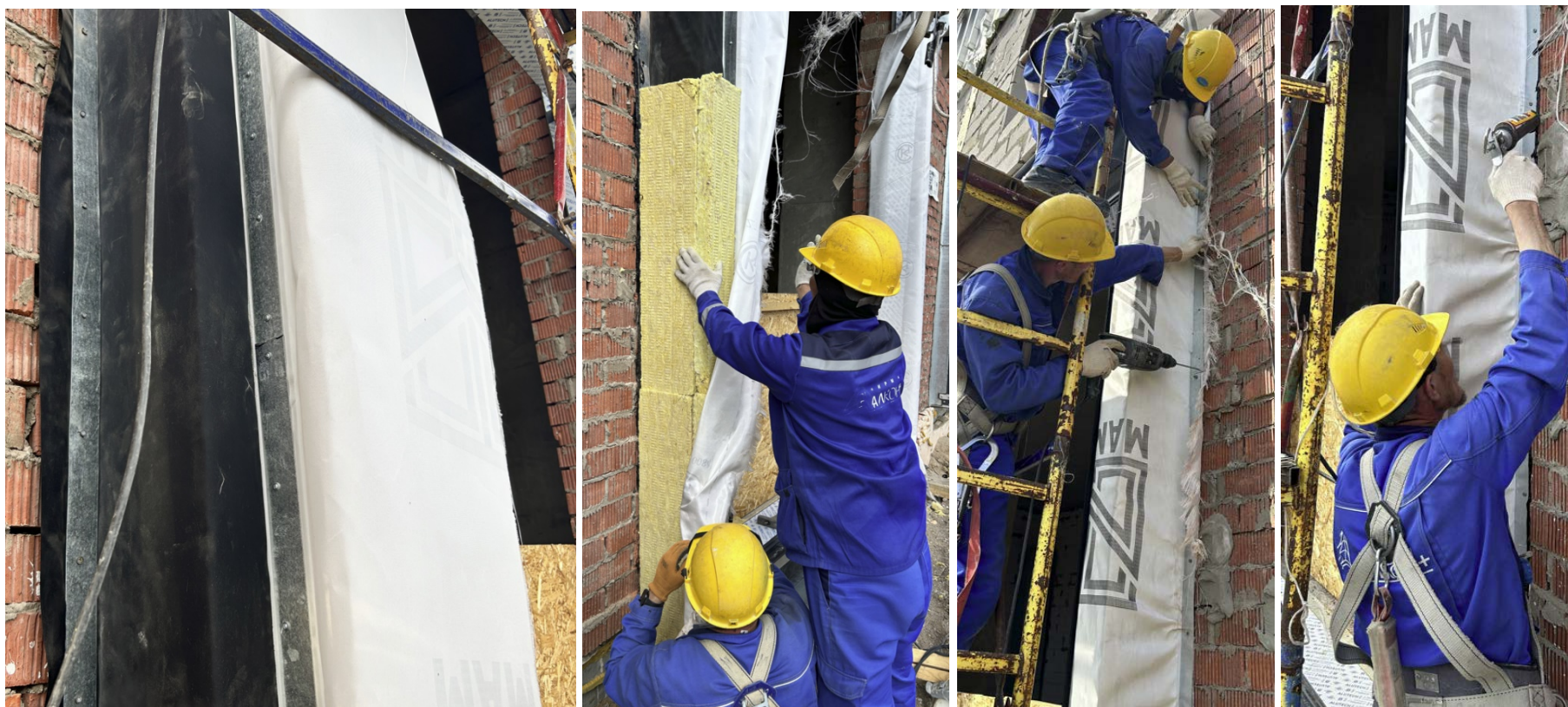
Рисунок 1.11 – Герметизация проема витражной рамы
