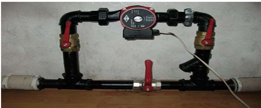
Рисунок 2.9 – Общий вид циркуляционного насоса в байпасной линии отопления
