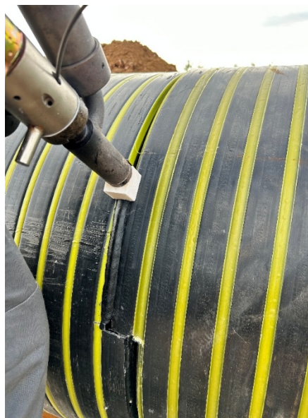
Рисунок 5 – Сварка стыков труб
