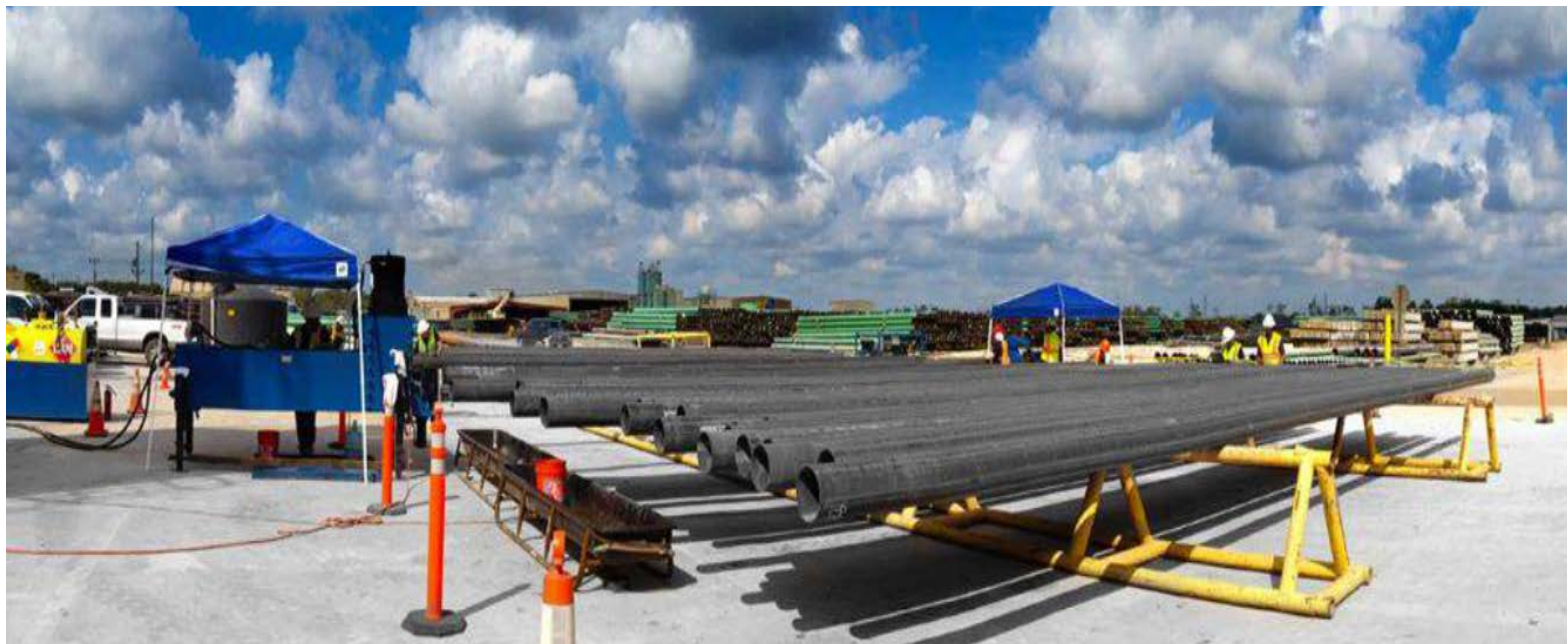
Рисунок 6 – Общий вид расстановки оборудования и стеллажей при подготовке концов труб
