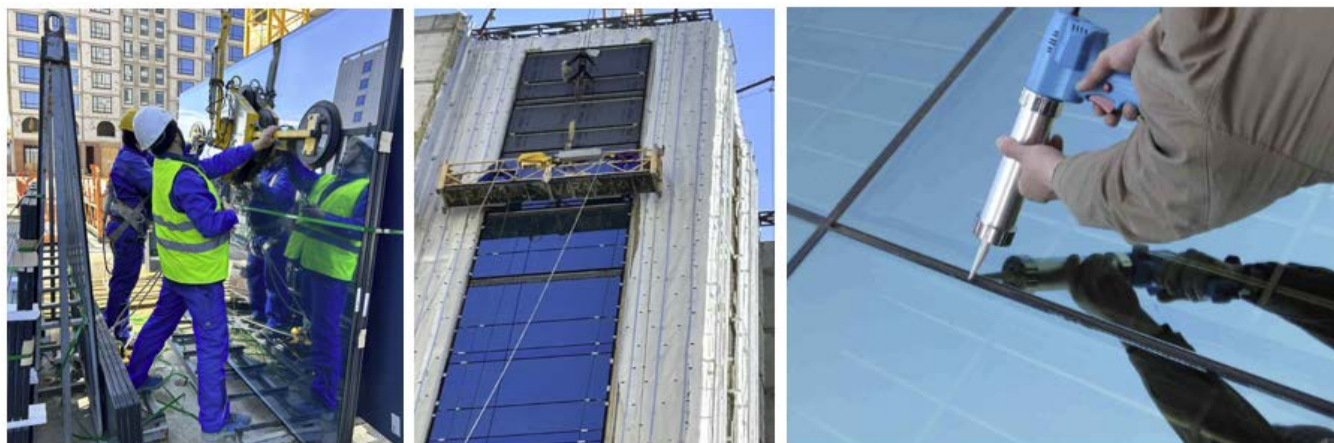
Рисунок 1.9 – Монтаж стеклопакетов
