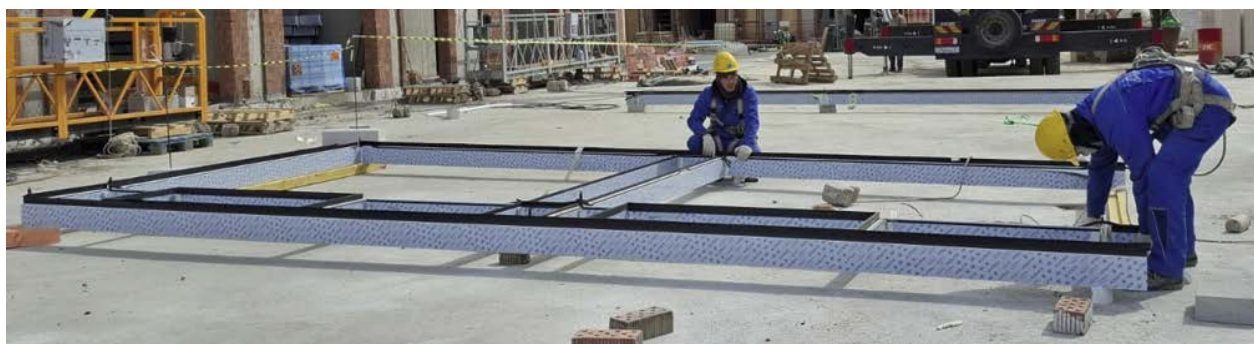
Рисунок 1.7 – Сборка рамы витражной
