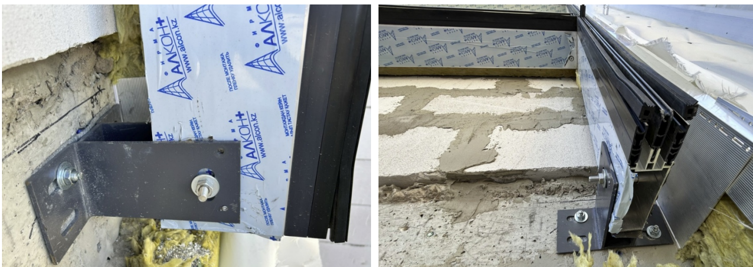
Рисунок 1.6 – Смонтированные кронштейны по плитам перекрытия
