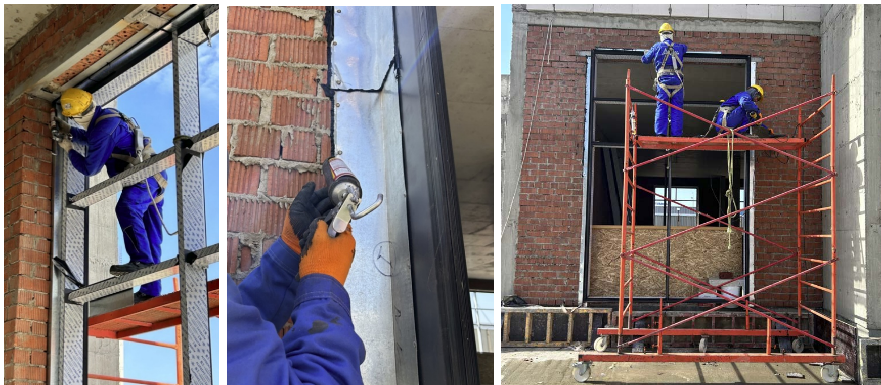
Рисунок 1.10 – Устройство противопожарной отсечки оцинкованной сталью периметра проема
