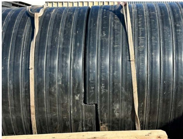
Рисунок 4 – Совмещение и центровка труб
